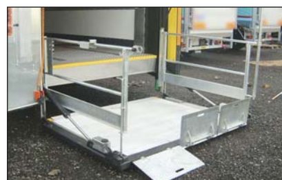
S751 Поручни для обеспечения безопасности смонтированы на направляющих лифта, а не на платформе
